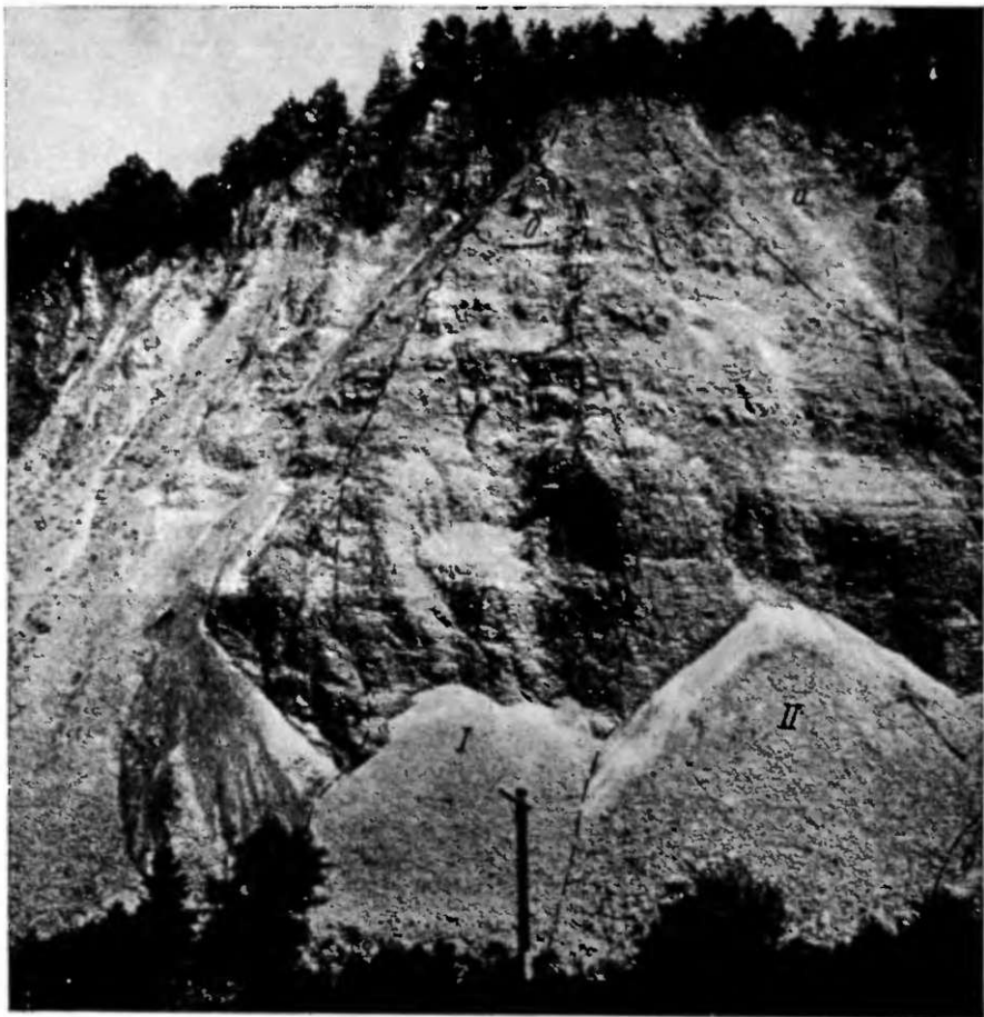
Рис. 1. Фотопанорама осыпного склона на правом берегу р. Хотевури.
