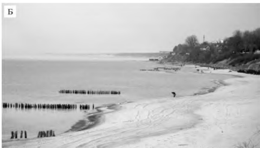
Рис. 5. Активный размыв пляжа при разрушении корневой части бун на косе Хель (А) и на севере Самбийского п-ова у Зеленоградска (Б)
