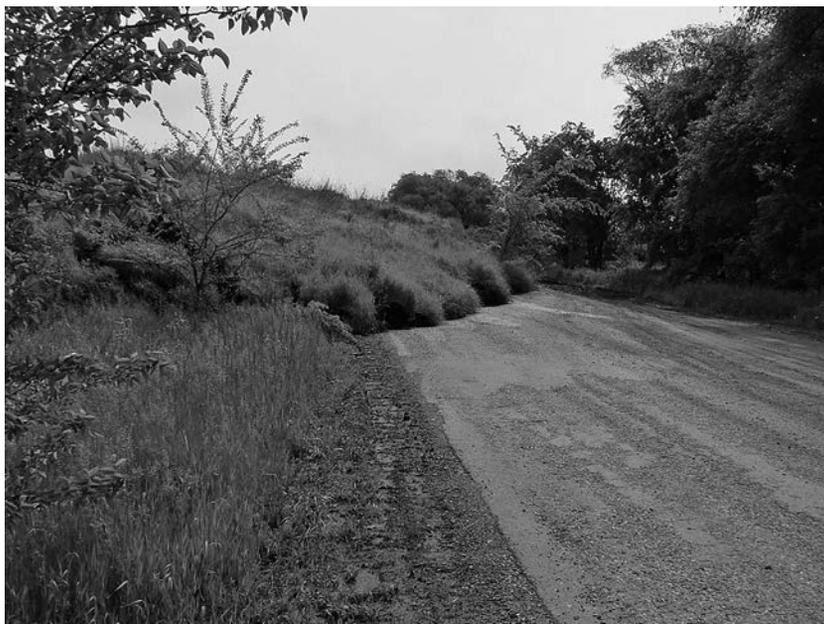
*Рис. 3. Наполнение оползневых масс на автодорогу*
