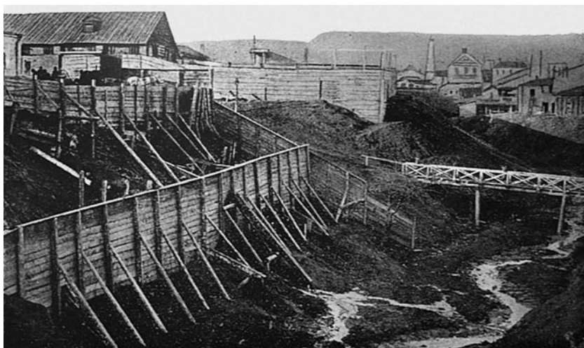
Рис. 1. Укрепление бортов одного из отвершков Глебучева оврага. Фото начала XX в. [12]
