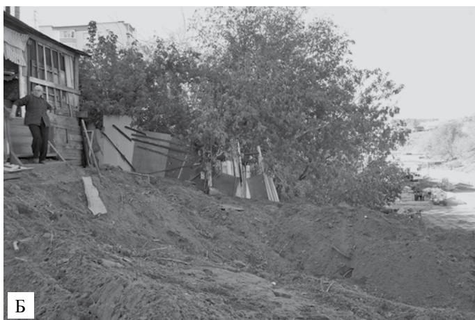
Рис. 3. Оползень в районе ул. Вальной, дом № 64
