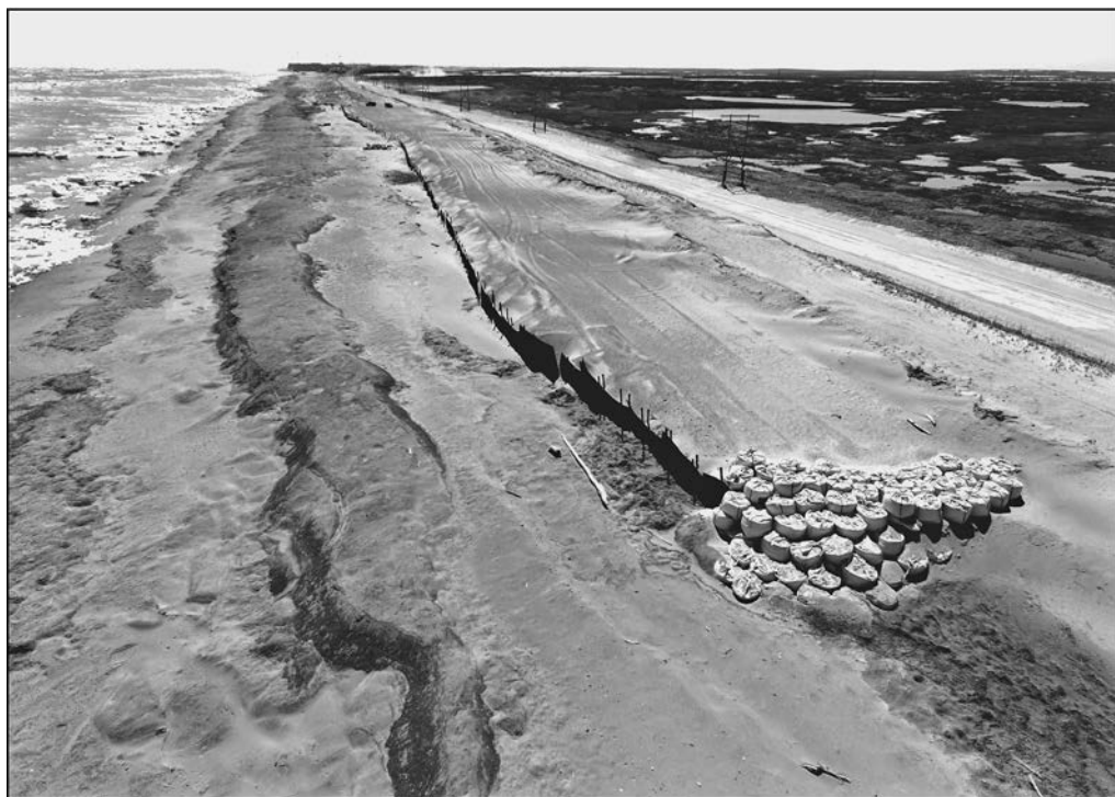
Рис. 6. Восстановленный в результате проведенного в сентябре 2016 г. искусственного разрушения мегафестонной структуры распределения береговых наносов пляж на участке размыва, произошедшего 22 октября 2015 г. Состояние после разрушения припая (31.05.2017)
