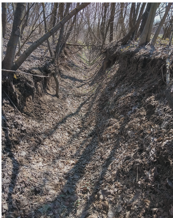
Рис. 1. Ров, образовавшийся в результате выемки железной трубы добытчиками металлолома на кагатном поле остановленного в середине 2000-х годов сахарного завода в с. Григорьевка Обуховского р-на Киевской обл. Весна 2021 г.
