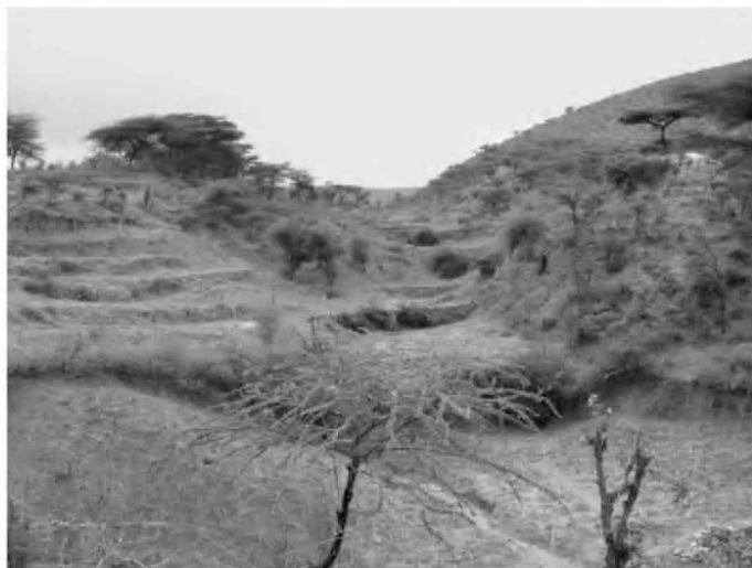
Рис. 4. Противозерозионные барражные стенки на склонах (окрестности г. Дыре-Дауа, фото Э.В. Запорожченко)
