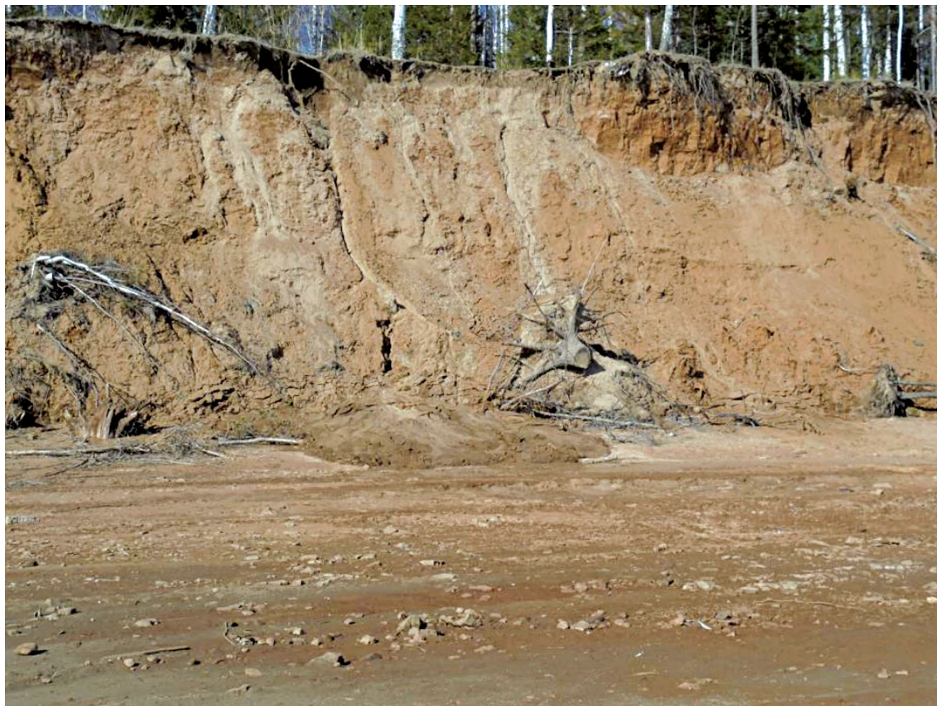
Рис. 4. Вынос материала по трещинам и образование конуса выноса у подножия абразионного склона на берегу Воткинского водохранилища (фото И. Е. Егорова).
