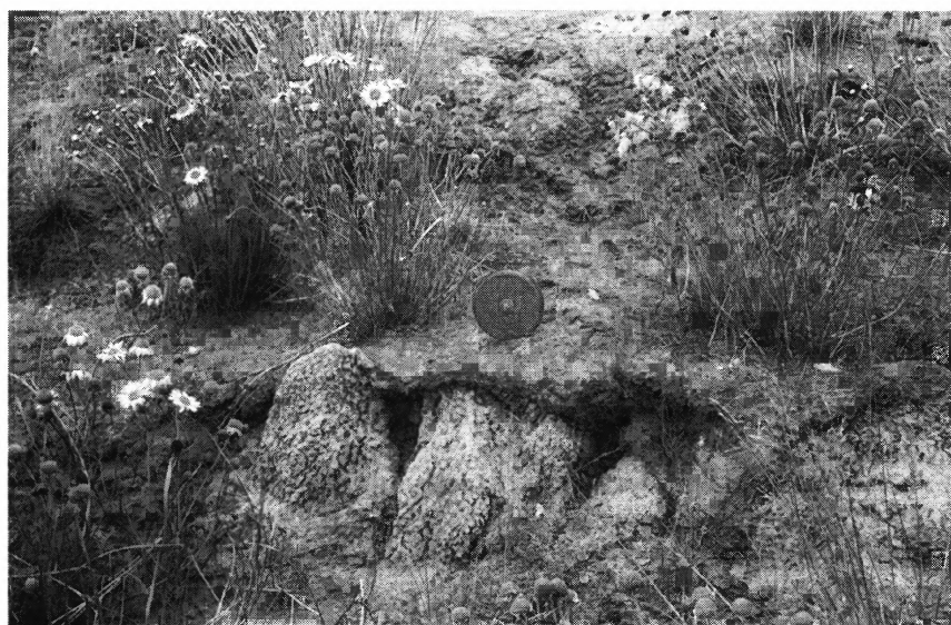
Рис. 3. Плащевидные и каплевидно-струйчатые натеки в нижней части откоса насыпи
