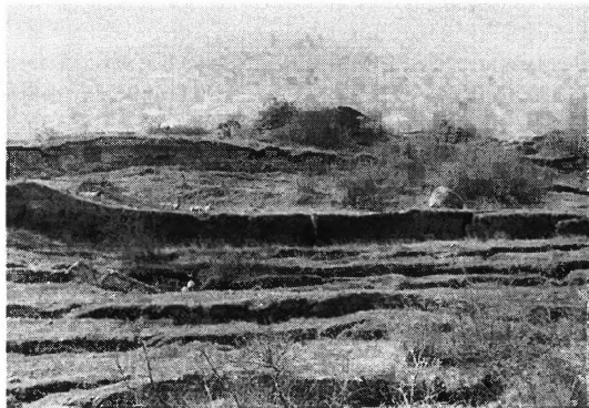
Рис. 3. Оползневые явления на объездной дороге вокруг Тбилиси
