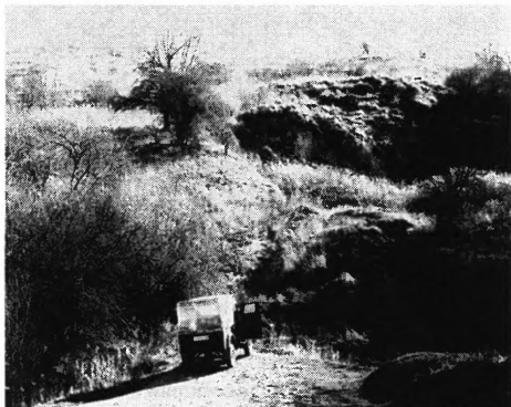
Рис. 2. Снесенный оползнем участок дороги (0,7 км) на перевале Гомбори
