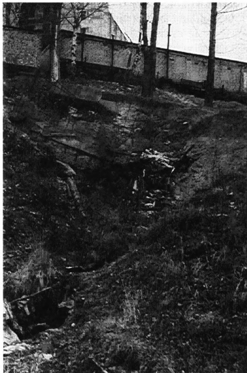
Рис. 3. Разрушенный быстроток
