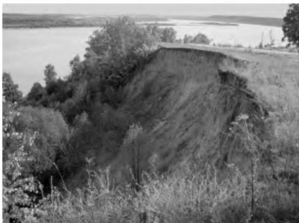
Рис. 2. Бровка и обрыв Нижегородского Окско-Волжского берегового откоса в районе с. Безводное Кстовского района на Волге На дальнем плане справа виден лобовой береговой откос
