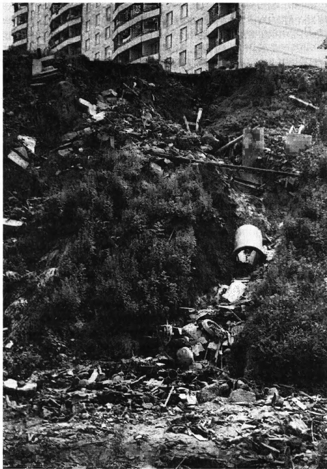
Рис. 6. Участок левого борта оврага в районе Винницкой улицы на правобережье р. Раменки в месте прорыва дренажной системы и водостока в верховьях засыпанной части оврага Произошло расширение левого борта оврага вблизи построенного дома. Новый донный врез на днище оврага представляет реальную угрозу для строения
