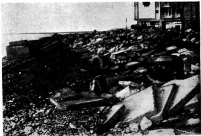
Рис. 2. Пищунда. Разрушение береговой стенки и набережной февральским штормом 1969 г.
