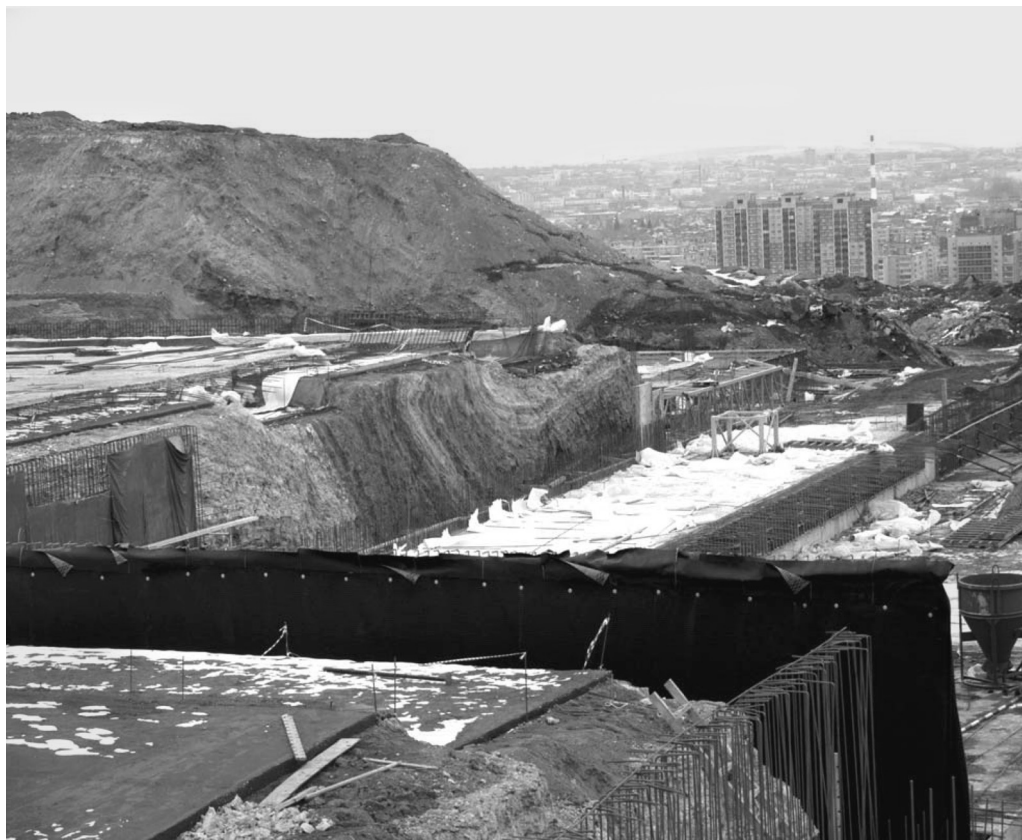
Рис. 3. Структурные несогласия в котловане под ТЦ “Планета”
