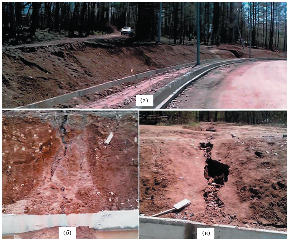
Рис. 2. Участок откоса автодороги с нагорной стороны, поврежденный экзогенными процессами после ливневых осадков – (а), оплывина на откосе, в результате вязкопластичной деформации грунтов (водно-гравитационный процесс) – (б) и промоина на откосе, в результате эрозии (флювиальный процесс) – (в).
